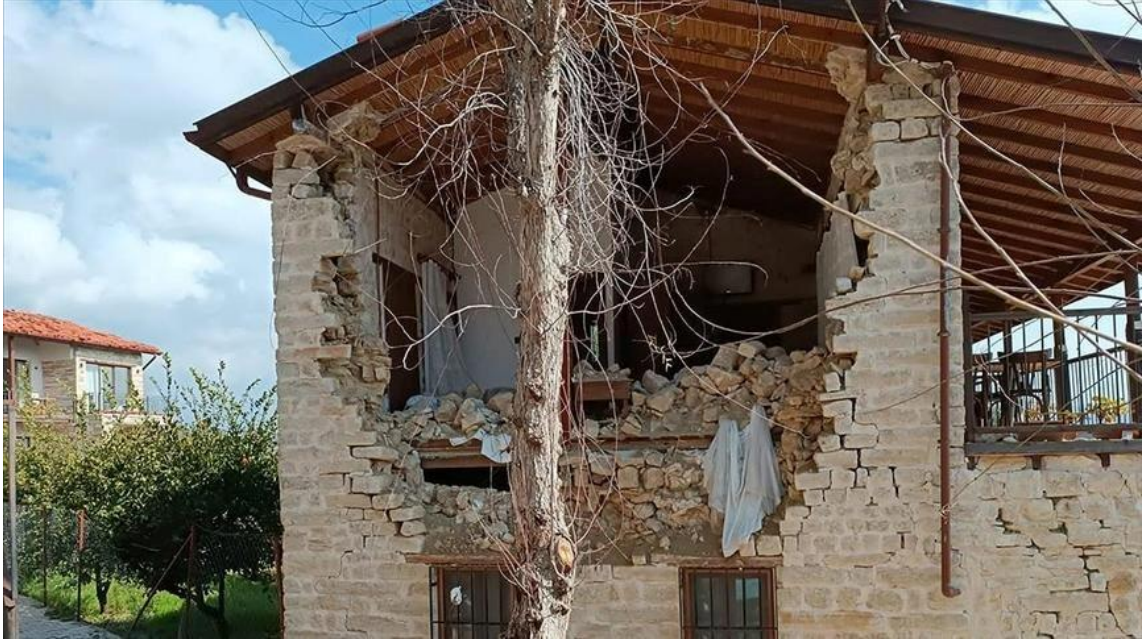
Şekil 11. Vakıflı Köyü Geleneksel Konut Örneğinin 2023 Depremleri Sonrası Hali (URL-1)
