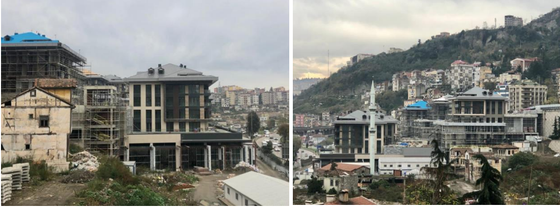
Şekil 8. Çömlekçi Mahallesi 1.etap proje alanı güney ve batı cephesi (Yazarlar tarafından düzenlenmiştir, 2023)
