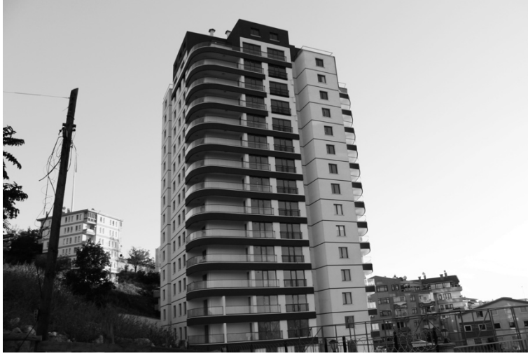
Şekil 7. Kampüsün güneyinde gecekondular bölgesinde inşa edilen yeni konut blokları (Azize Elif Yabancı, 2023)
