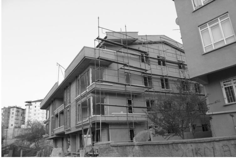
Şekil 9. Cebeci ara sokaklarında bir kentsel dönüşüm projesi inşaatı (Azize Elif Yabacı, 2023)
