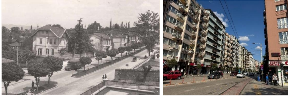
Şekil 4. Solda: Kaymakamlık binasından Altıparmak Caddesi'nin görünümü ( www.bursa.bel.tr ). Sağda: Yüksek Katlı Yapılaşmaya Sahip Altıparmak Caddesi'nin Günümüze Ait bir görünümü.
